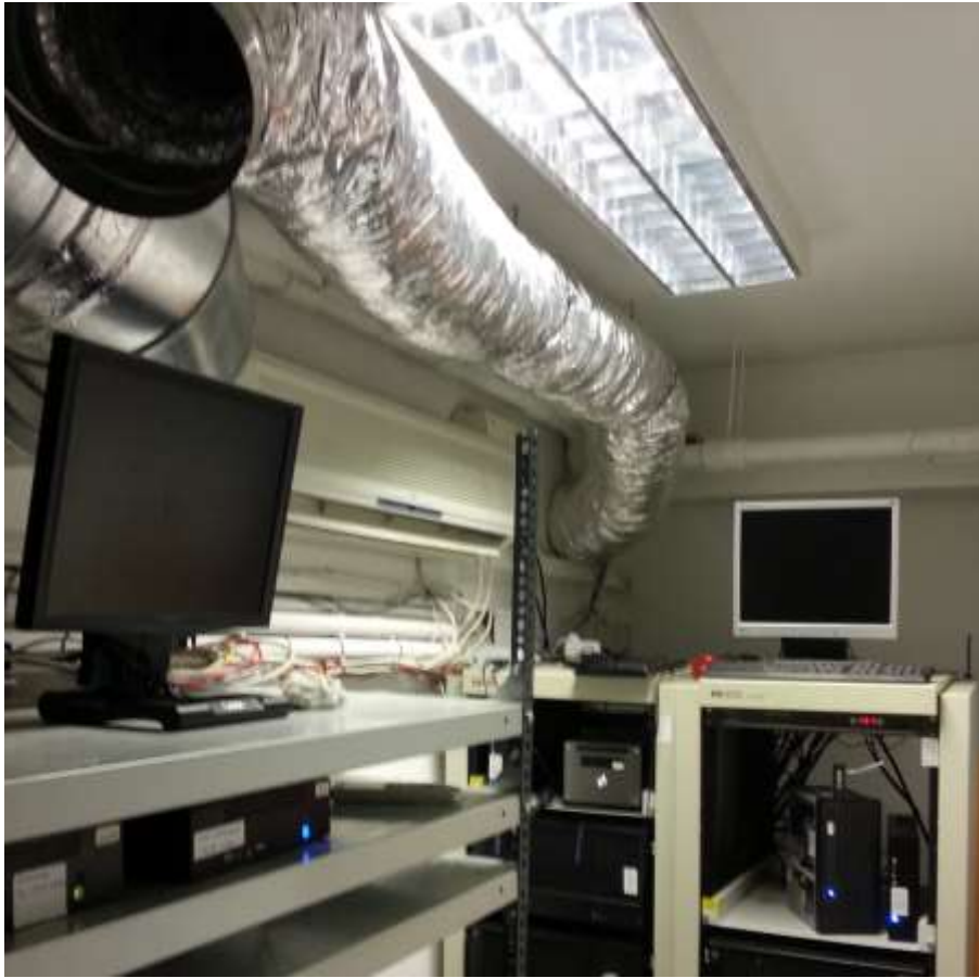
4. ábra: Szerverszoba kombinált hűtés
